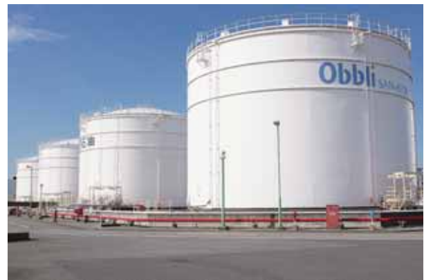
航空燃料の貯油タンク (羽田空港)
