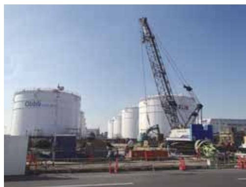
貯油タンク増設工事の様子
