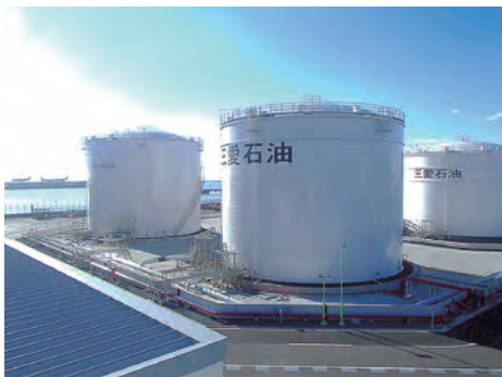
②④ 三愛石油、新貯油タンク完成 2020 増設工事を進めていた航空燃料用の貯油タンク 2 基が完成した
