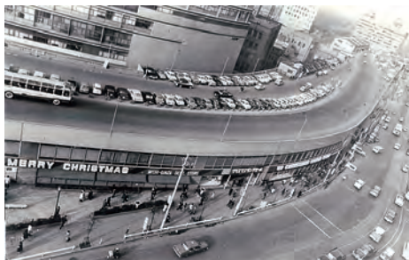
⑤ 西銀座デパート設立 1958 数寄屋橋の堀が埋め立てられ、開通した高速道路下に日本初のショッピングセンターとして開店
