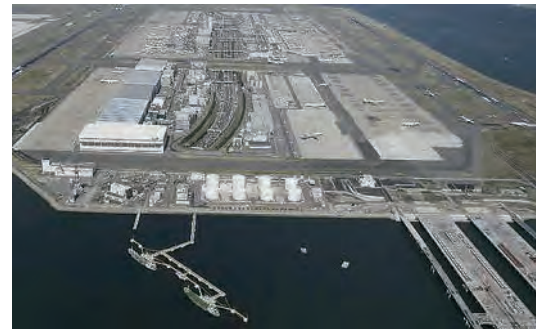
②1 三愛石油、羽田空港再拡張事業に伴う工事完了 2010 国際線地区給油施設の建設、貯油基地タンクの増設、新棧橋建設を行った
