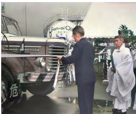
三愛石油羽田営業所開設式 (1952.10.27) 燃料タンク車が飛行機のところまで行って給油している様子を眺めているとき、水道のようにホースを引っ張ってきて給油すれば効率が上がるとひらめいた。この着想がやがてハイドラントシステムによる給油となる
