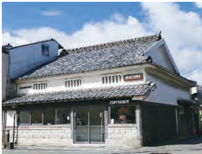
古民家に移設した萩事業所の外観
