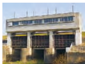
向堀河排水樋門（茨城県）
