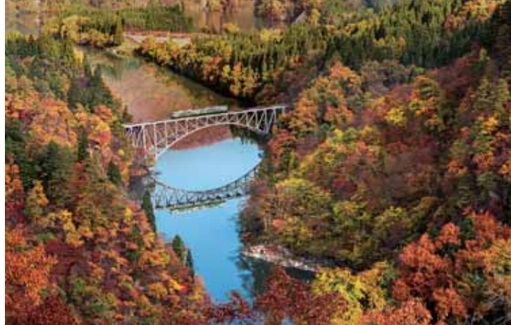
只見線の絶景の代表格「第一只見川橋梁」
