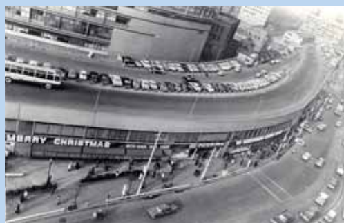
上空から見た西銀座デパート 店舗の上を高速道路が走る
