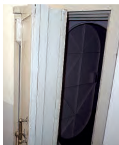
万が一に備えて設置された「地下シェルター」
