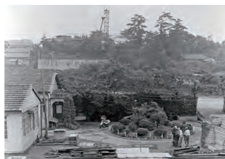
建設中（写真奥）、手前は理研光学大森工場の敷地（1954年）
