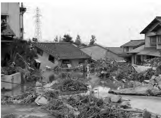
2004年10月20日 台風23号(知人が撮影) 兵庫県円山川堤防決壊により豊岡市の半数の民家が浸水。 この台風で友人の父親が水死した
