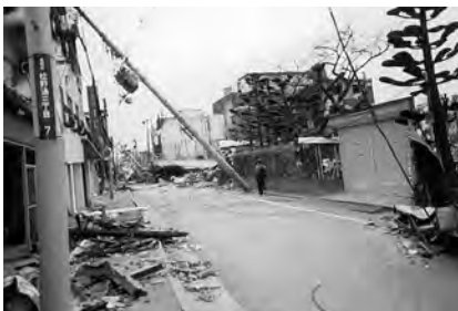
自宅付近の被災状況
